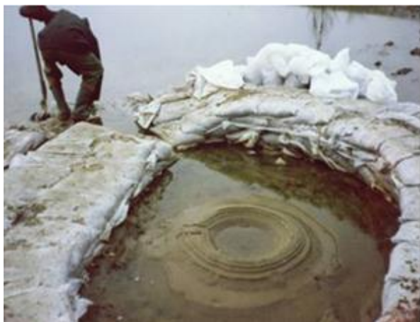
5. sz. képcsoport: A buzgár kiépített ellennyomó medencéje
