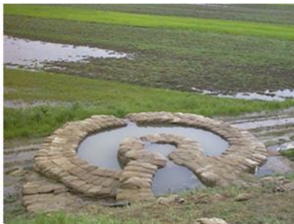
5. sz. képcsoport: A buzgár kiépített ellennyomó medencéje
