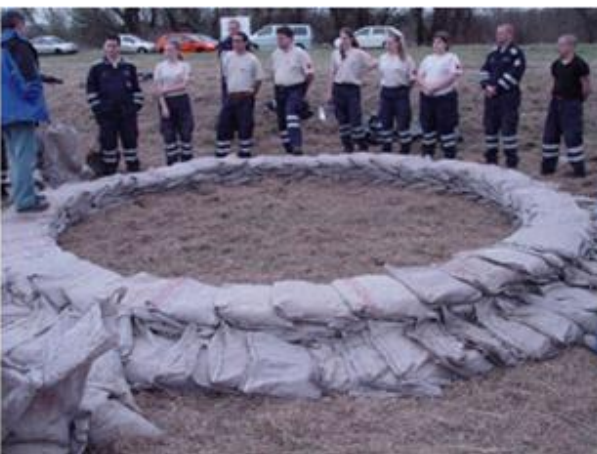
6. sz. képcsoport: A buzgár ellennyomó medencéjének kiépítése
