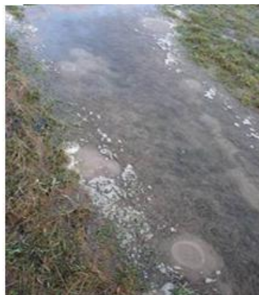
2. sz. kép: Buzgár csoport. Védekezés a jelenségek összevonásával, szorítógaállal.
