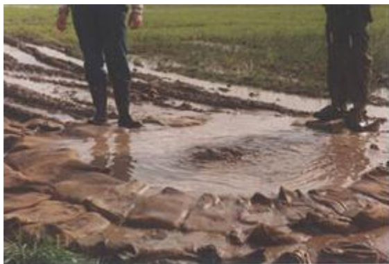
3. sz. kép: Buzgár közvetlenül a felfedezése után
