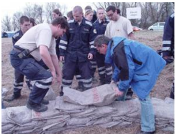
6. sz. képcsoport: A buzgár ellennyomó medencéjének kiépítése
